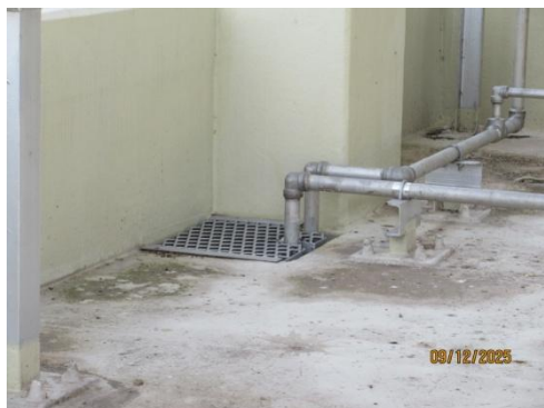
รูปที่ 3-47 รางระบายสารเคมี บริเวณจัดเก็บสารเคมี
