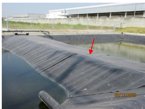
รูปที่ 3-11 การปูพื้นบ่อพักน้ำทิ้งด้วย HDPE
