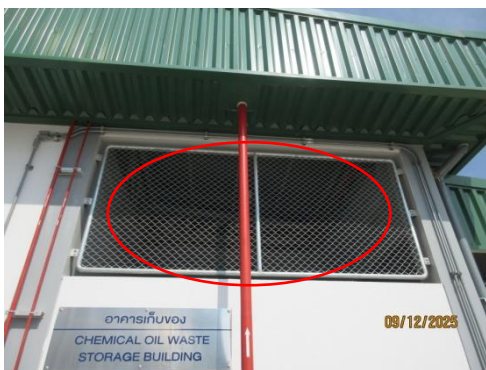
รูปที่ 3-45 ระบบระบายอากาศบริเวณ จัดเก็บสารเคมี
