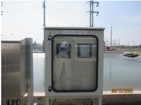
รูปที่ 3-13 เครื่องมือตรวจวัดคุณภาพน้ำทิ้งแบบต่อเนื่อง
