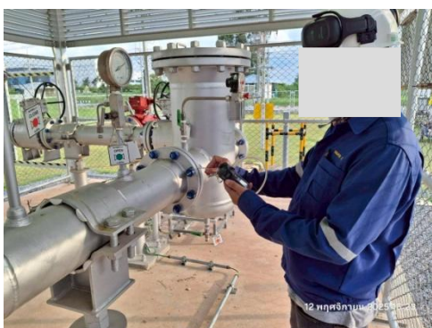
รูปที่ 3-54 การใช้ Portable Gas Detector ตรวจจับการรั่วไหลของก๊าซธรรมชาติ บริเวณสถานี MRS
