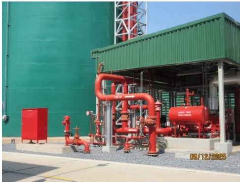
รูปที่ 3-36 ระบบป้องกันเพลิงไหม้และระบบดับเพลิง
