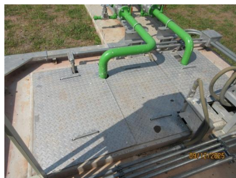
รูปที่ 3-12 บ่อตรวจสอบคุณภาพน้ำ (Inspection Pit)
