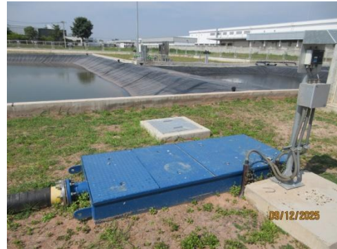
รูปที่ 3-14 บ่อแยกน้ำ/น้ำมัน (Oil Separator)
