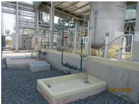
รูปที่ 3-43 ที่ล้างตา ที่ล้างมือและหน้า และฝักบัว ชำระล้างร่างกายบริเวณจัดเก็บสารเคมี
