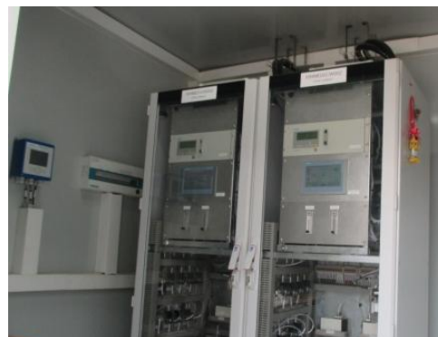
รูปที่ 3-2 ระบบตรวจวัดการระบายสารมลพิษทางอากาศจากปล่องระบายอากาศแบบต่อเนื่อง (CEMS)
